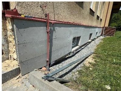
Připevnění cementovláknitých desek na rošt, nové oplechování
