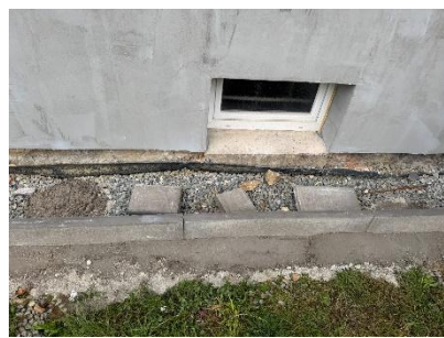
Penetrační a základový nátěr, pokrytí mozaikovým marmolitem
