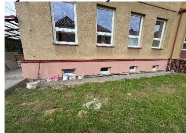
Penetrační a základový nátěr, pokrytí mozaikovým marmolitem
