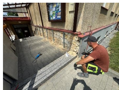
Otlučení omítky sokle, připevnění roštu – budova ZŠ 100
