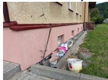
Penetrační a základový nátěr, pokrytí mozaikovým marmolitem
