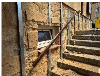
Otlučení omítky sokle, připevnění roštu – budova ZŠ 100
