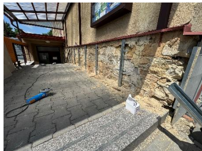
Otlučení omítky sokle, připevnění roštu – budova ZŠ 100
